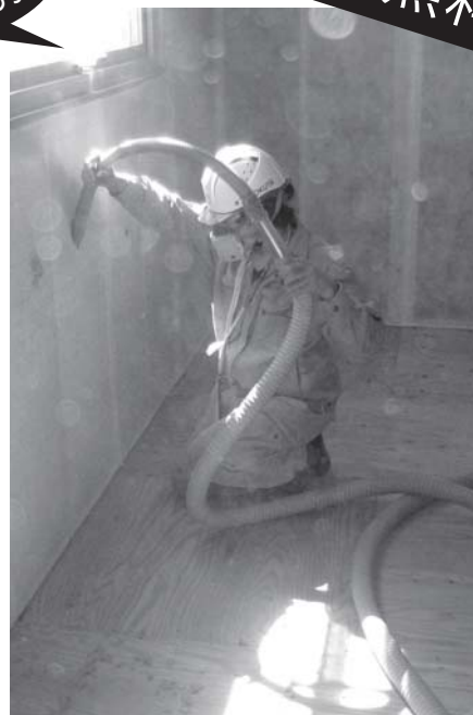
吹込施工見学
