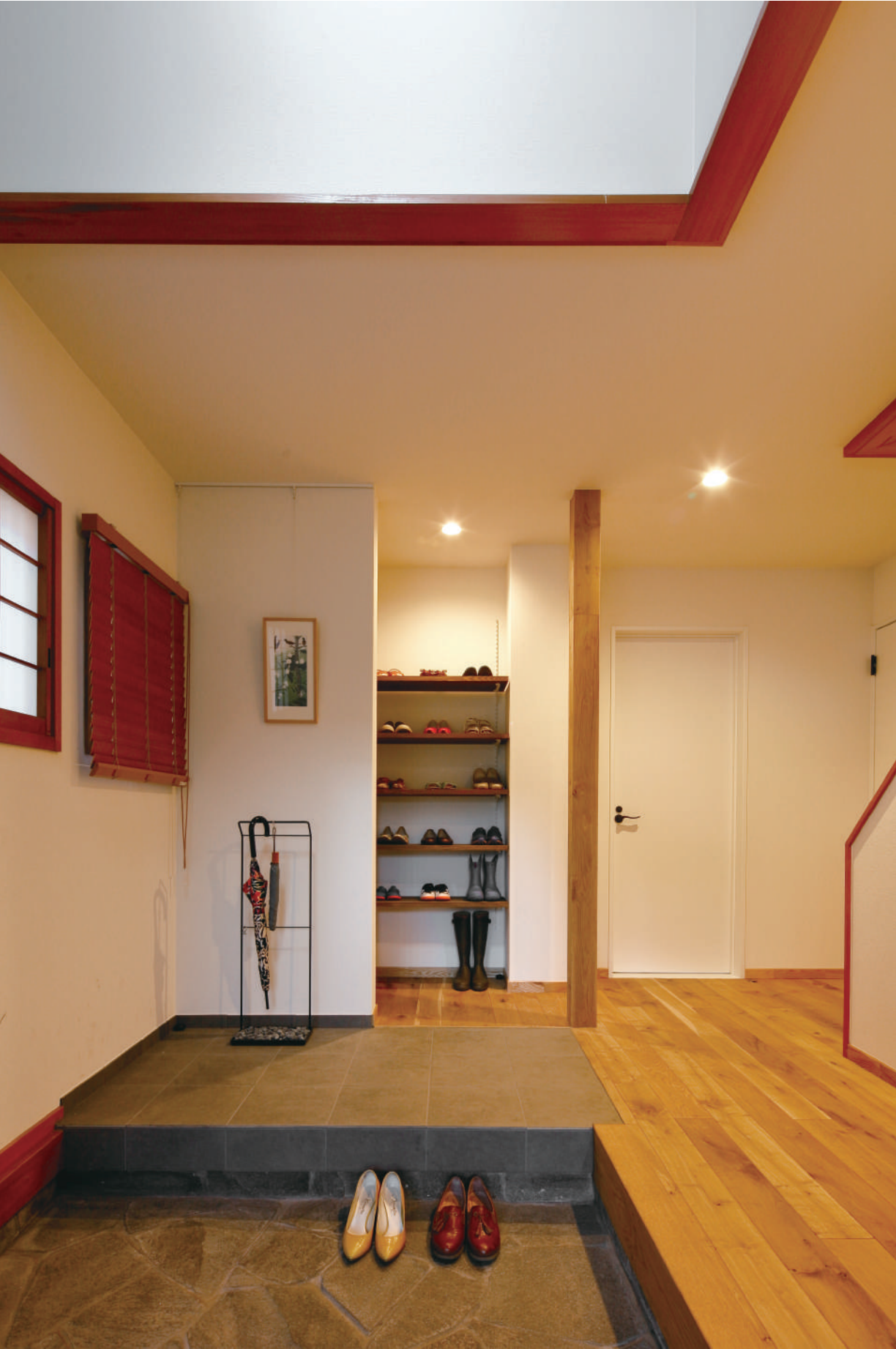
1 階の床高と面を合わせた玄関のあがり部分は、タイルを張ることで玄関と居室の境界をあえて曖昧にし、空間を広く見せると同時に汚れを気にせずに済む使いやすいスペースとなった。(L-MSY-R3080) OKUTA
